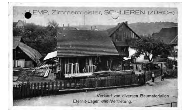
67 © 24.1.1919 Werkhof Zimmerei Lemp (Schul-/Uitikonstrasse)
