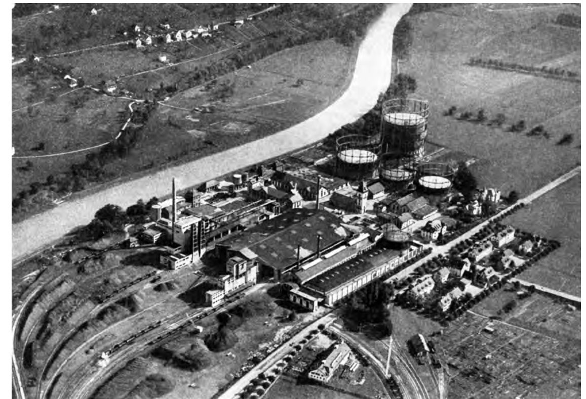
95 ca. 1930 Flugaufnahme Walter Mittelholzer, Gaswerk von Westen her
