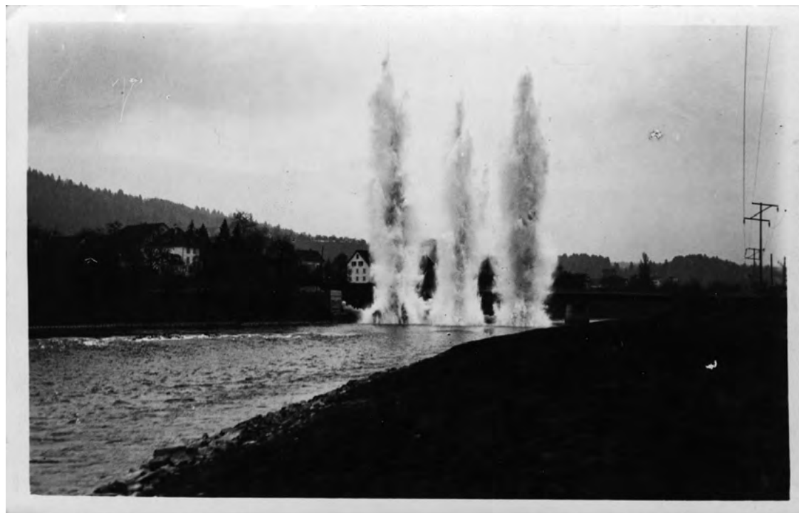
94 ca. 1935 Sprengung der Brückenfundamente
