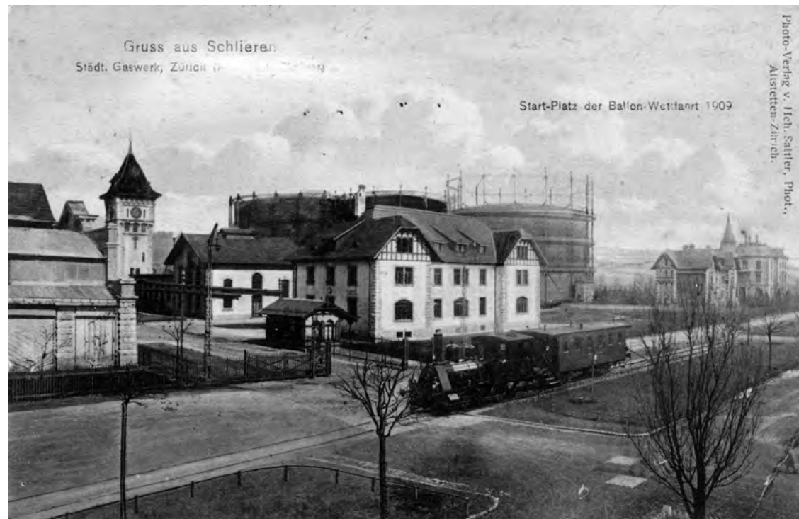
52 © 10.3.1911 Gaswerk mit Arbeiterzug
