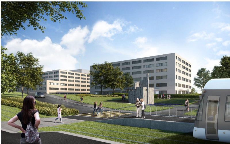
Ansicht von Nordwesten / Haltestelle Limmattalbahn
