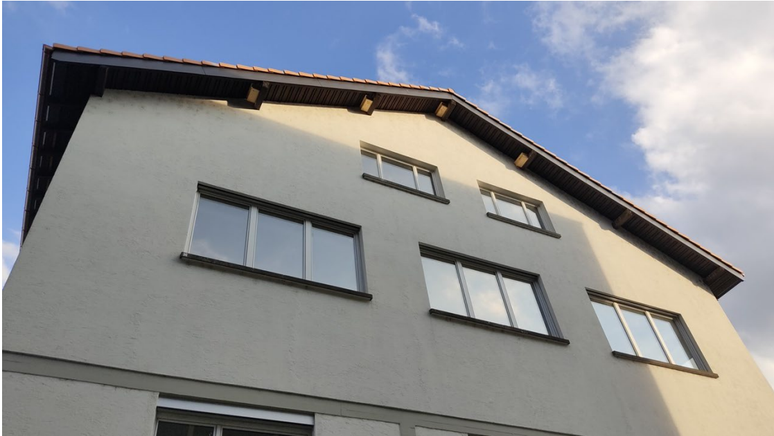
Abb.2: Neu installierte Mauerseglernistkästen an der Zürcherstrasse 137.
