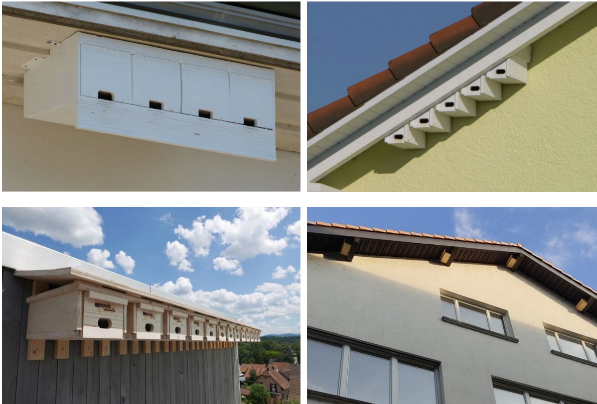
Abb. 1: Beispiele für Mauersegler-Nistkästen. Unten rechts die vier Kästen an der Zürcherstrasse 137 in Schlieren. Die Kästen sollten so platziert werden, dass die starke Sonneneinstrahlung ab Mittag nicht direkt auf die Kästen trifft, damit sie nicht überhitzen. Allenfalls ist auch ein Sonnen- und Wetterschutz nötig, wie beispielsweise im Bild unten links.
