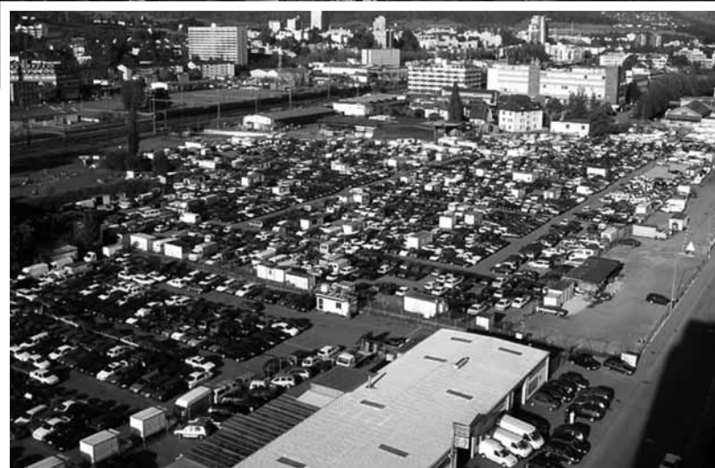
Oben: Die Brandstrasse mit den neuen Gebäuden auf dem ehemaligen Färbiareal Unten: Die Autooccasions-Halden (hier auf dem Färbi-Areal) schädigten Schlierens Image lange Zeit
