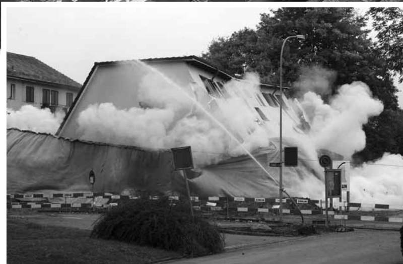
Oben: Die neue GEWOBAG-Überbauung Giardino wurde von 2005 bis 2010 gebaut Unten: Die alte GEWOBAG-Siedlung im Zelgli-Quartier wurde abgerissen
