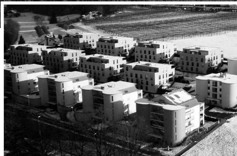
Oben: Das noch unüberbaute Gebiet Trisler/Hofuren Unten: Die fertiggestellte Siedlung fügt sich gut in die Umgebung ein
