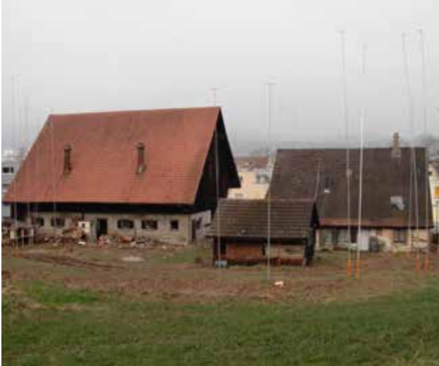
Der Abbruch naht, die Bauvisiere stehen schon, 2008.
